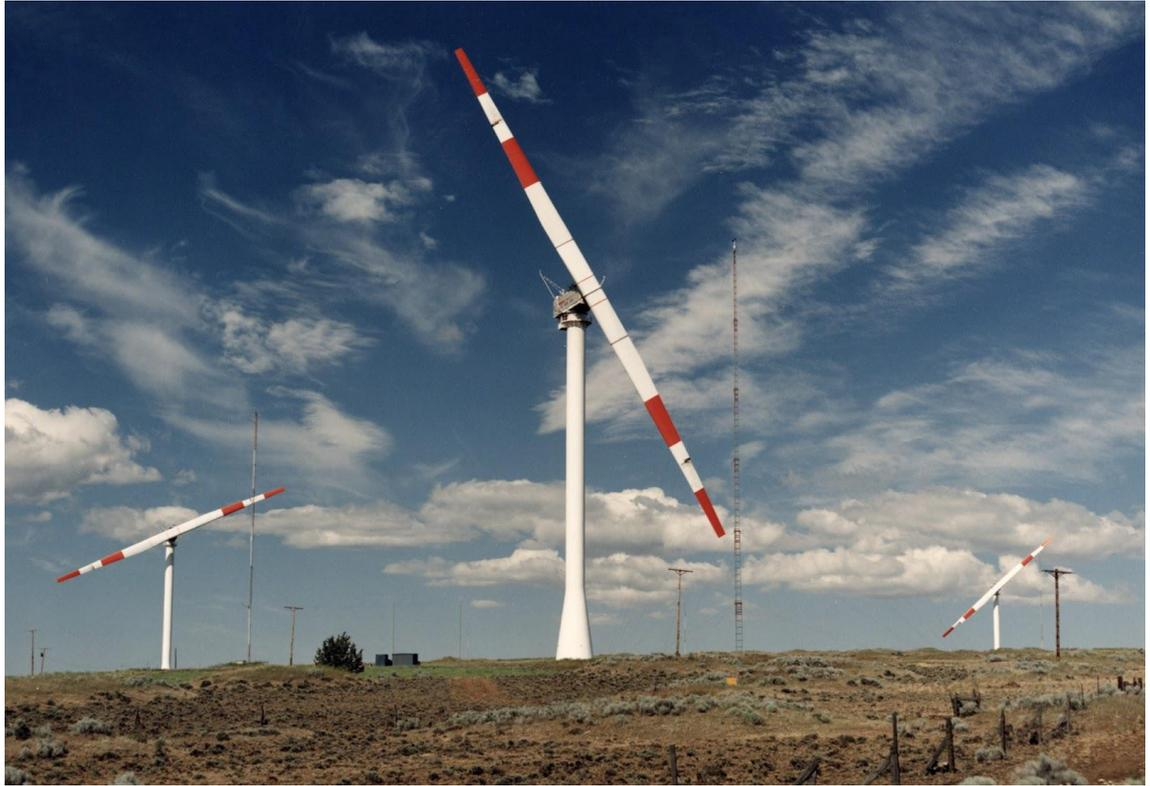
*Ilustración 38. Aerogeneradores bipala*
