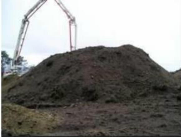
*Ilustración 55. Ejemplo de acopio de tierra vegetal que se usará para la restauración del lugar.*
