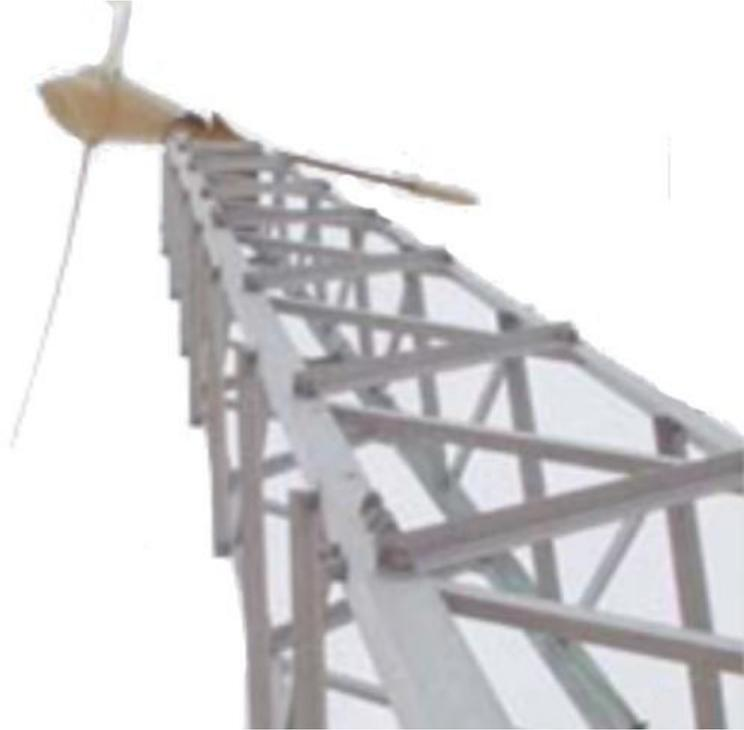
*Ilustración 41. Ejemplo de aerogenerador con torre de celosía*
