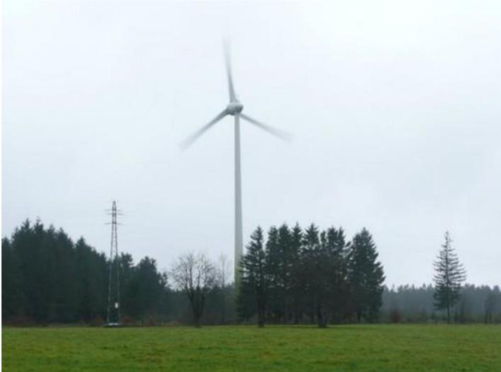
*Ilustración 45. Aerogenerador tripala ENERCON modelo E-33*
