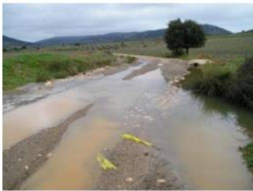
*Ilustración 51. Ejemplo de un vial con un sistema de drenaje deficiente de drenaje*
