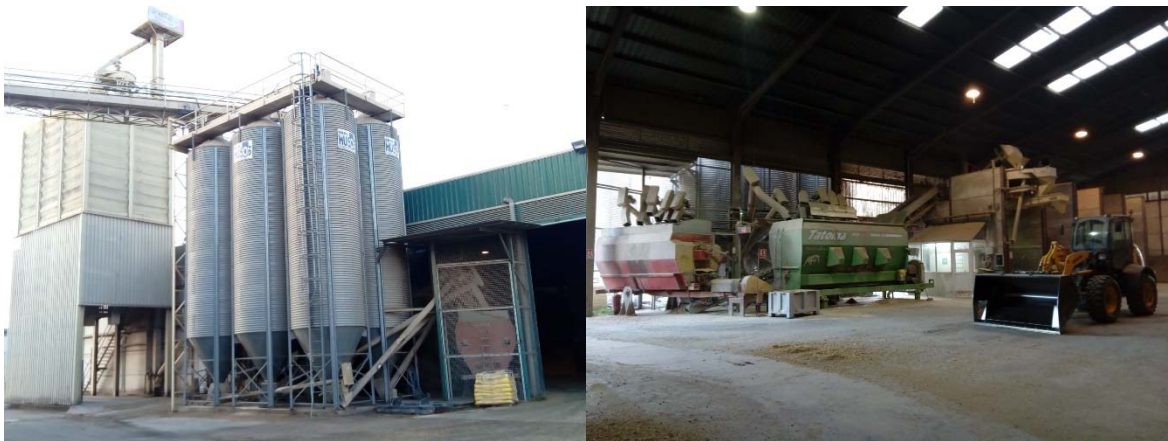
Figura 23 y 24. Vista exterior e interior de la fábrica de mezclas
