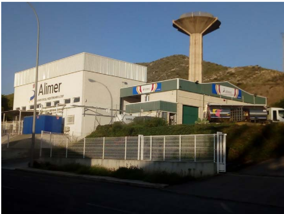
Figura 18. Instalaciones del centro de recogida de leche
