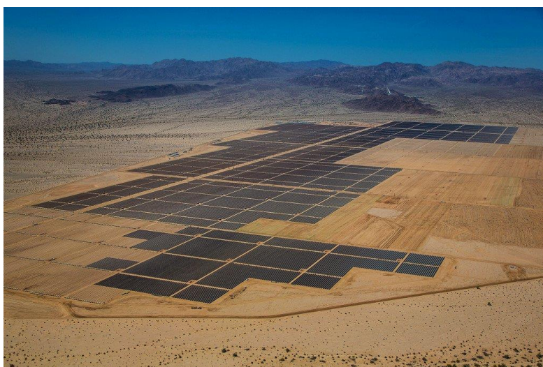
Figura 3.8 Vista aérea de la planta Topaz, en California. First Solar
