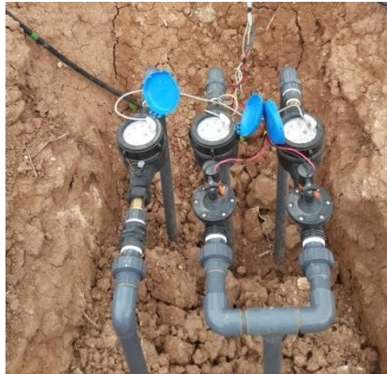
Figura 10: Detalle de sectorización para los distintos tratamientos de riego.
