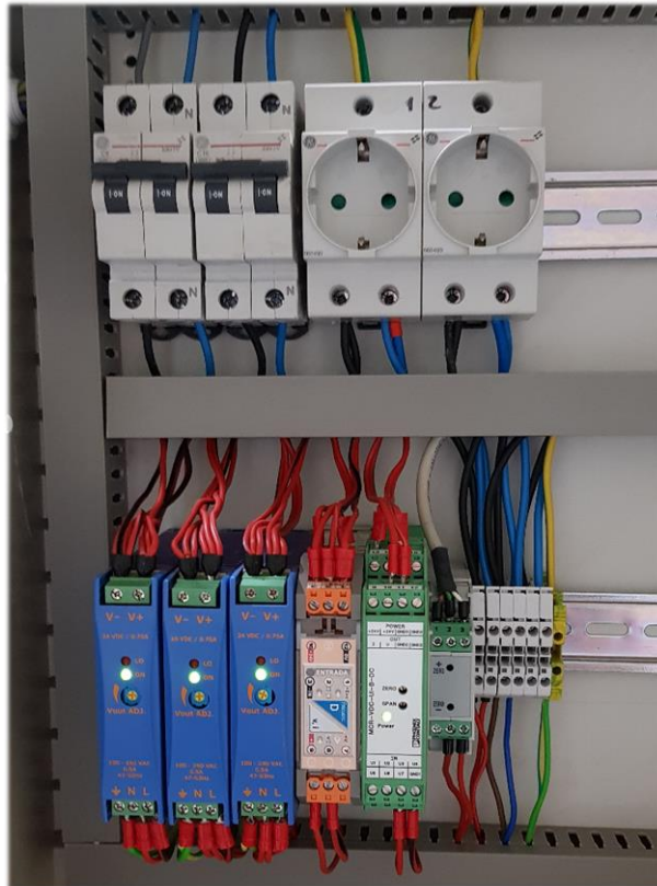
Ilustración 18. Fuentes de alimentación de 230VAC a 24VDC.
