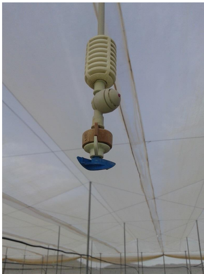
Foto 18: Detalle de microaspersor de boquilla marrón y bailarina azul.
