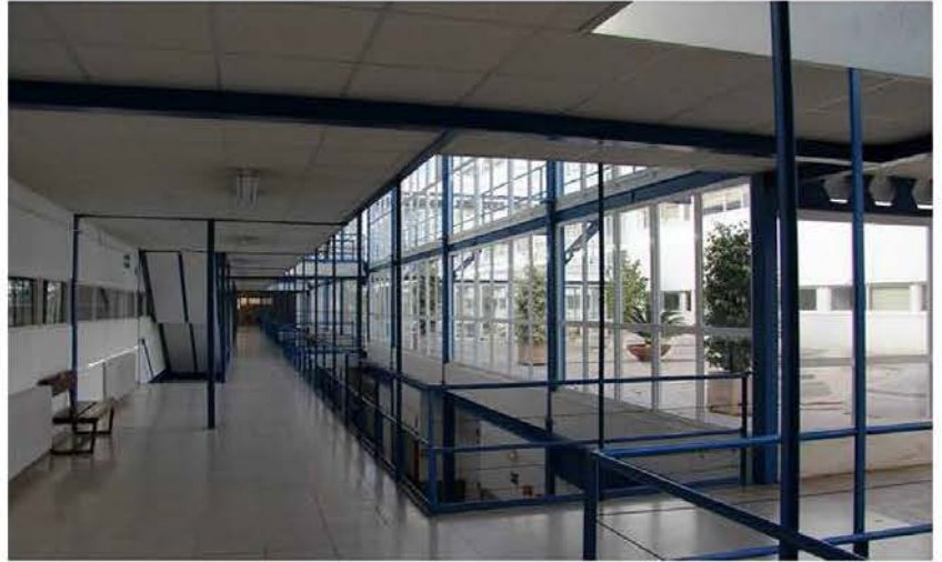
[7, 8 Y 9] ALEJANDRO DE LA SOTA, EDIFICIO DE AULAS Y SEMINARIOS DE LA UNIVERSIDAD DE SEVILLA, 1972. [UNIVERSIDAD DE SEVILLA] [P+C]
