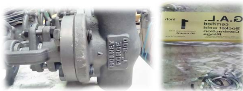
Figura 4 y 5: Válvula Socket Weld / Conjunto de Gap-a-let Fuente: Elaboración Propia
