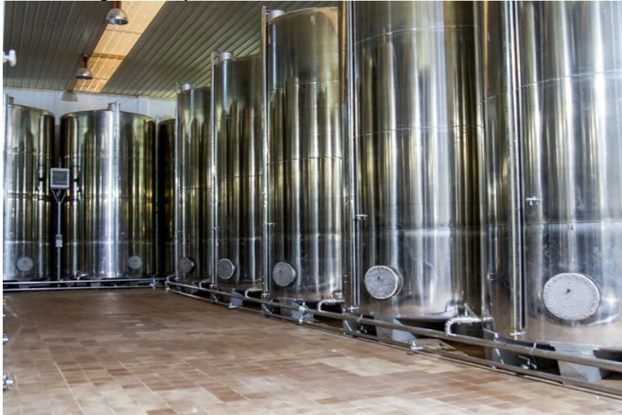
Figura 33 Depósitos de almacenamiento de aceite de oliva
