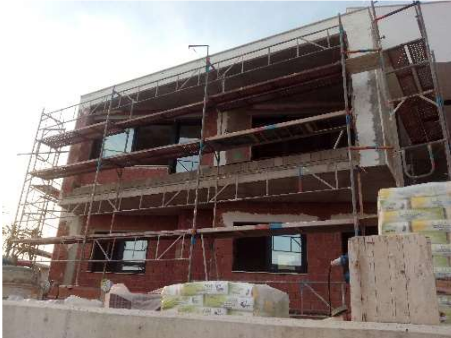
Imagen 12 Fachada capuchica con huecos
