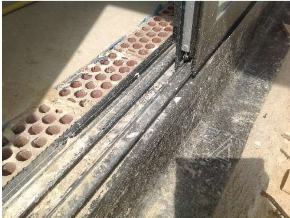
Imagen 8 Alfeizar impermeabilizado paso de puerta
