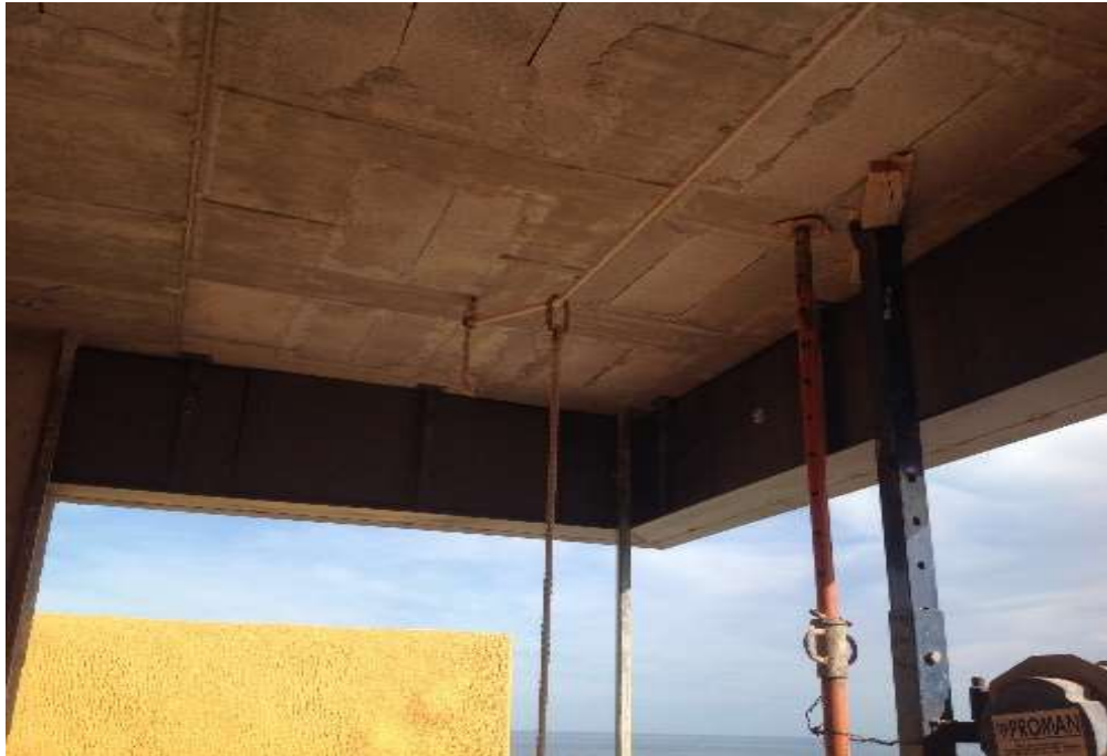
Imagen 10 Dintel cerrado exterior
