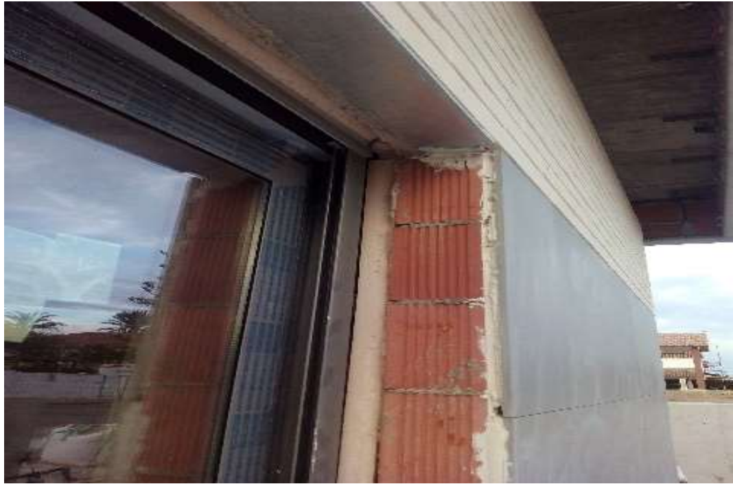
Imagen 5 Dintel de chapa de acero galv.
