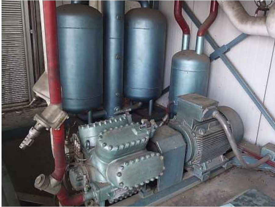
Fig 15. Equipo de refrigeración industrial para R22-R407C
