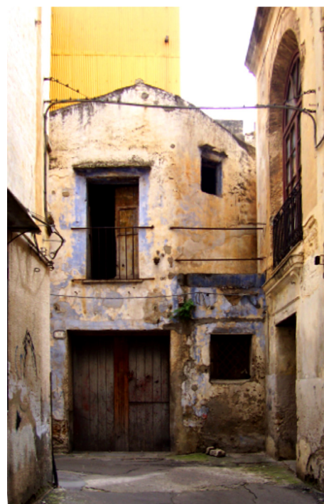
[FIG. 12]. ALTOFONTE (PALERMO), CASA IN VIA DEL COLLEGIO.
