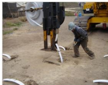
Figura 2.21 Proceso de instalación de mechas drenantes. “Nuevo acceso al Puerto de San Antonio” (Chile)
