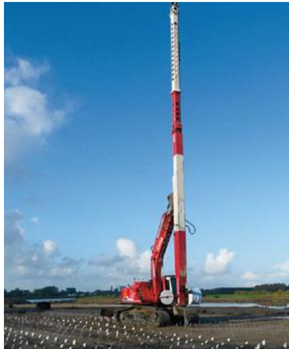
Figura 2.16 Maquinaria usada para la colocación de mechas drenantes
