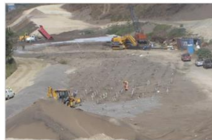
Figura 2.21 Proceso de instalación de mechas drenantes. “Nuevo acceso al Puerto de San Antonio” (Chile)
