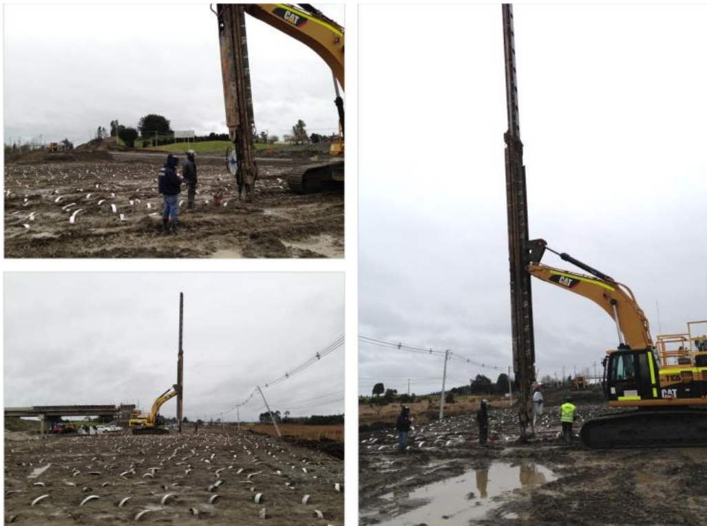
Figura 2.19 Proceso de instalación de mechas drenantes. “Enlace La Goleta” (Chile)
