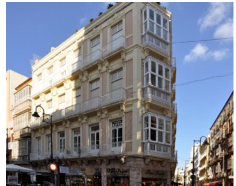
[FIG. 18]. VISTA ACTUAL DEL ALUMBRADO PÚBLICO DE LA CALLE DEL CARMEN DESDE LAS PUERTAS DE MURCIA, DISEÑADO POR EL ARQUITECTO RAFAEL BRAQUEHAIS. (FOTOGRAFÍA DE LAS AUTORAS).
