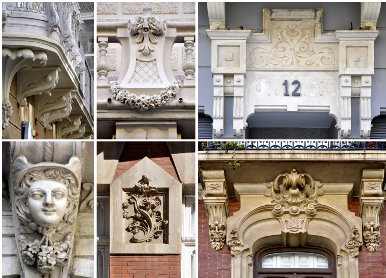
[FIGS. 12, 1-2-3-4-5-6]. DETALLES DE INTERÉS UBICADOS EN LOS EDIFICIOS: 1. CASA CÁNOVAS; 2. PALACIO DORDA; 3. CASA GARNERO; 4. PALACIO PEDREÑO; 5. EDIFICIO MARTÍNEZ VERA; Y 6. CASA DE JOSÉ NIETO ASENSIO. (FOTOGRAFÍAS DE LAS AUTORAS).
