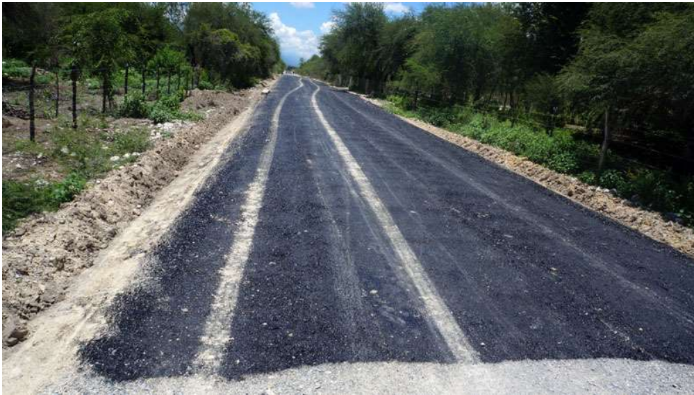
Figura 15. Camino de zahorra estabilizada con una capa de riego asfáltico.
