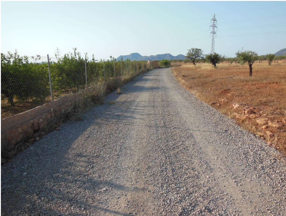
Figura 12. Camino de zahorra estabilizada.
