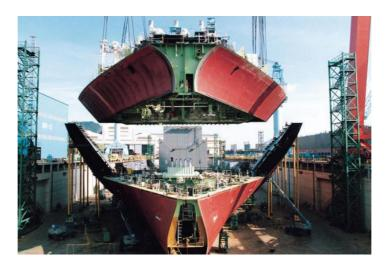
Imagen 19: Construcción del buque por secciones (Atmosferis, 2013)
