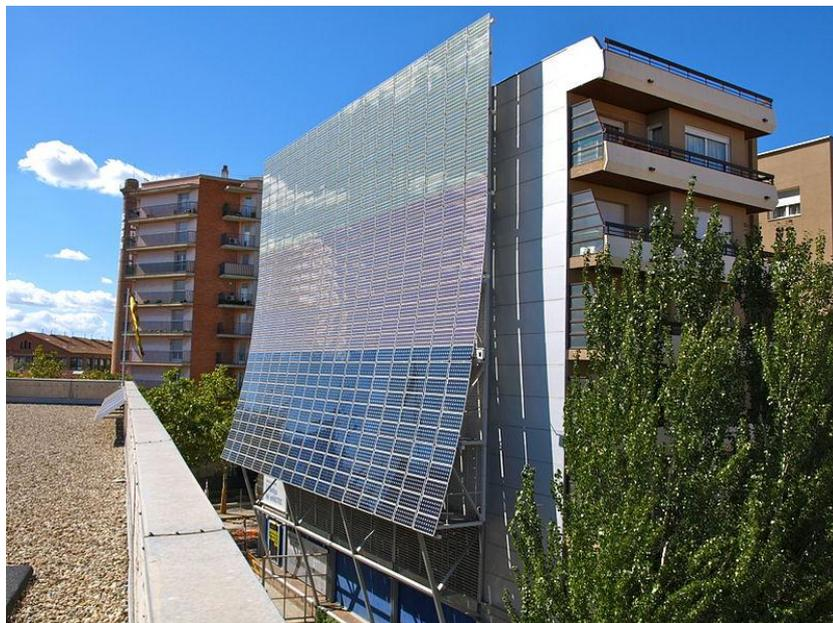
**Fig. 1. Fachada fotovoltaica en el edificio MNACTEC (Tarrasa, España)**
