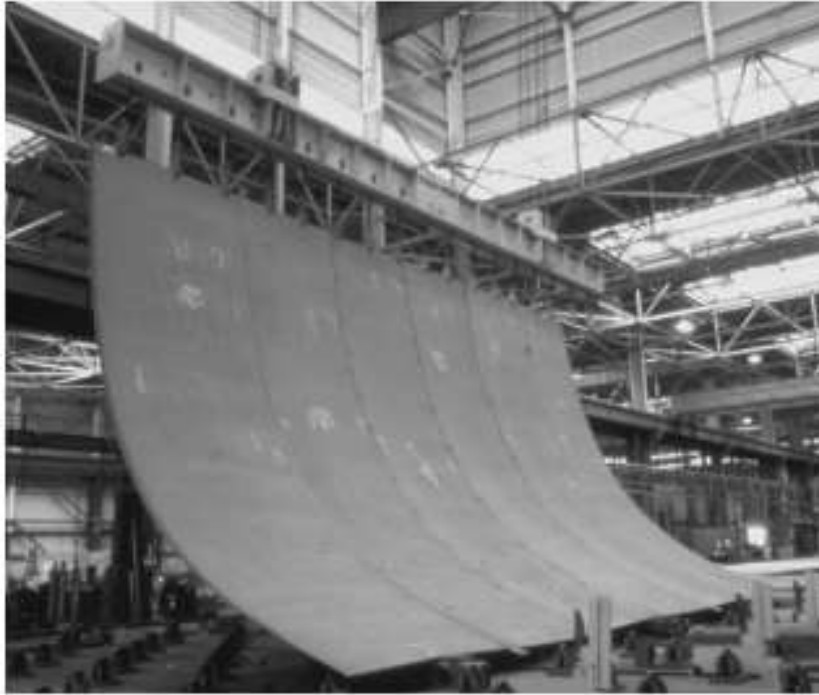
Figura 4. 23. Curvado de las planchas.
