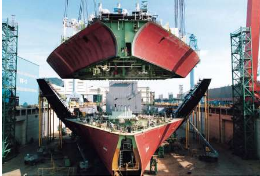
Figura 4. 33. Ensamblaje bloques en grada
