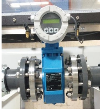
Figura 4. Caudalímetro electromagnético
