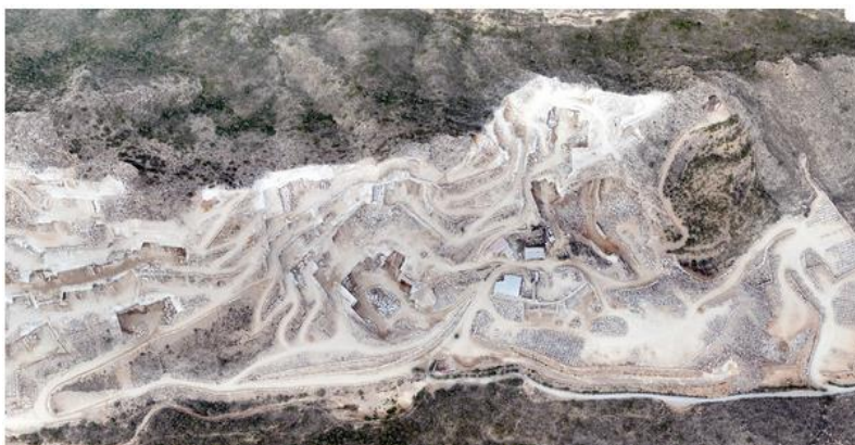
Imagen 18. 100 ha de cantera a cielo abierto (Habitat Serea, 2015).
