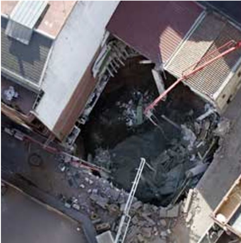
Imagen de uno de los socavones
