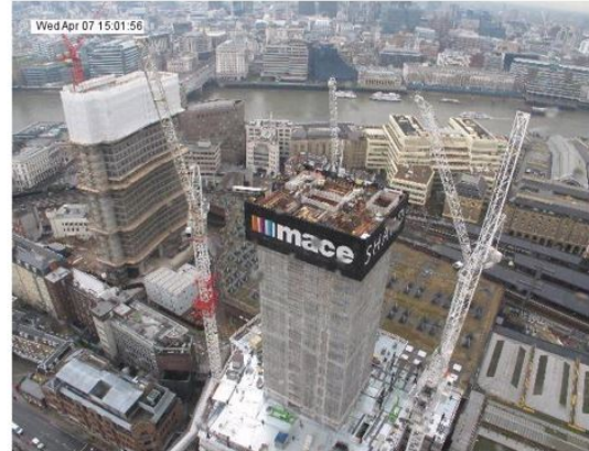
Edificio con encofrado autotrepante
