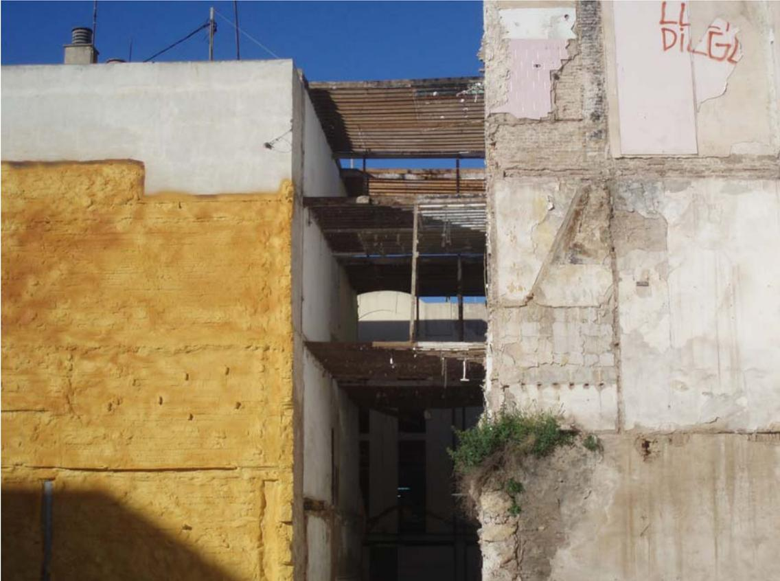
*Vigas que forman parte de edificios colindantes, ejemplo de elementos que no puede demolerse*
