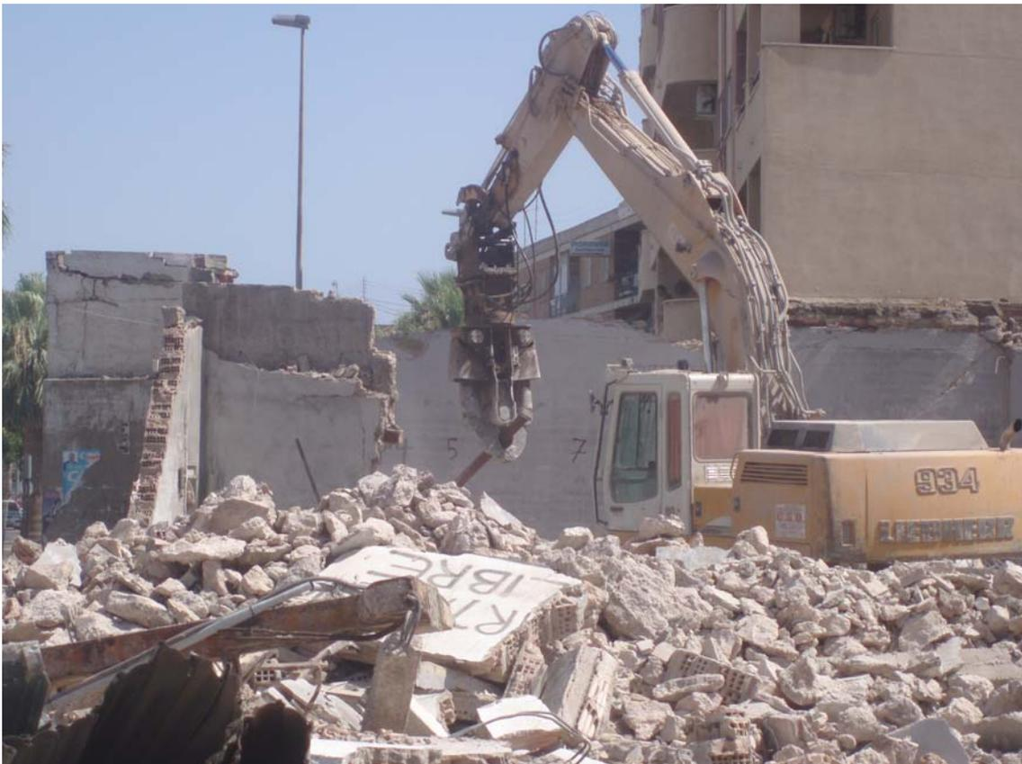
*Maquina de demolición por mecánica hidroneumática, pinzas demoledoras.*
