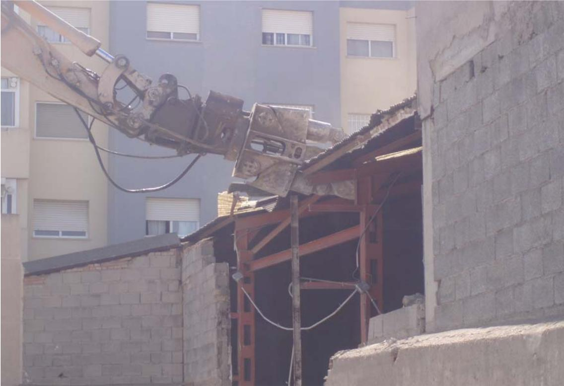
*Detalle de pinza demoledora en demolición de cercha.*
