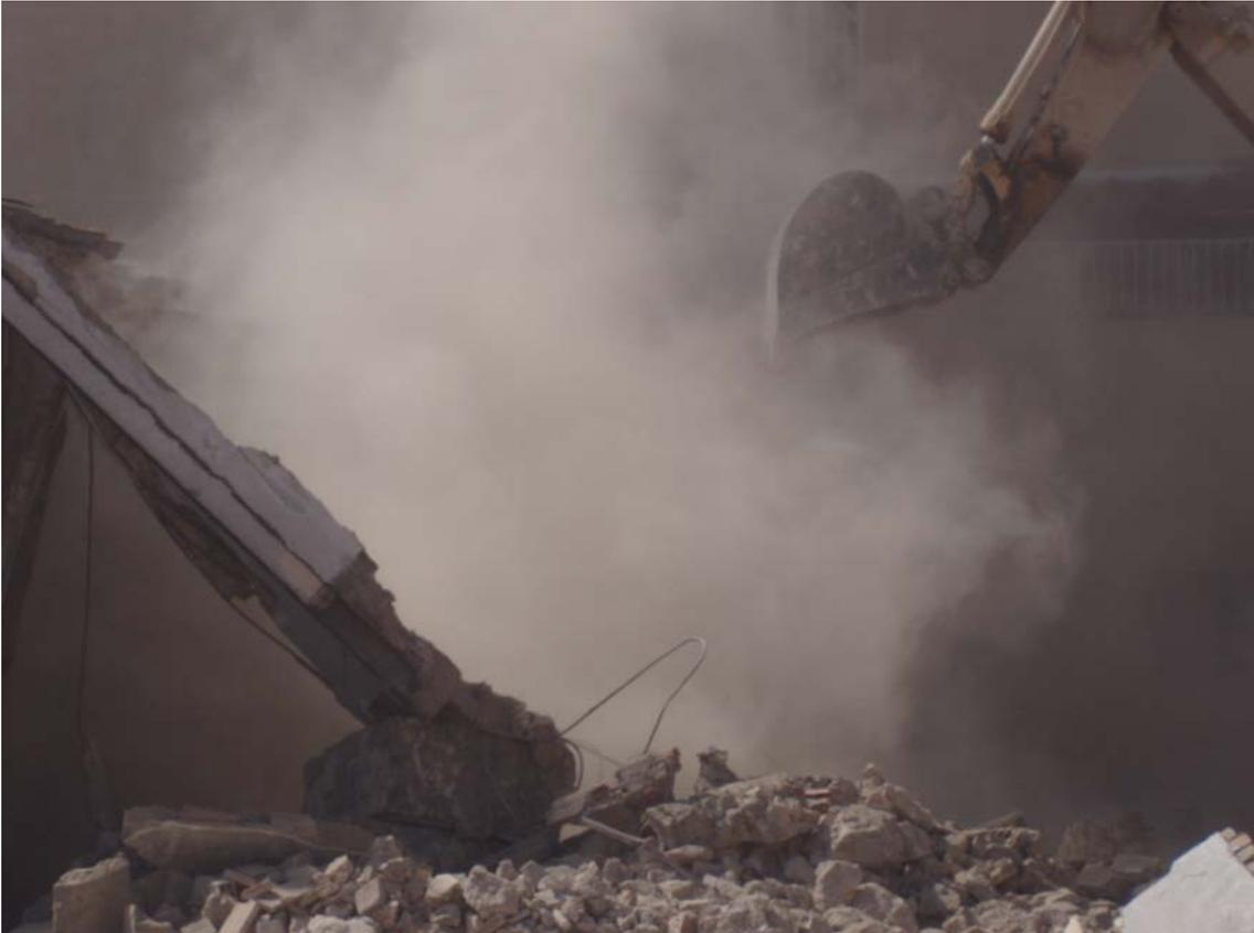
*Emisión de humos producida por la demolición de una cubierta de láguena*
