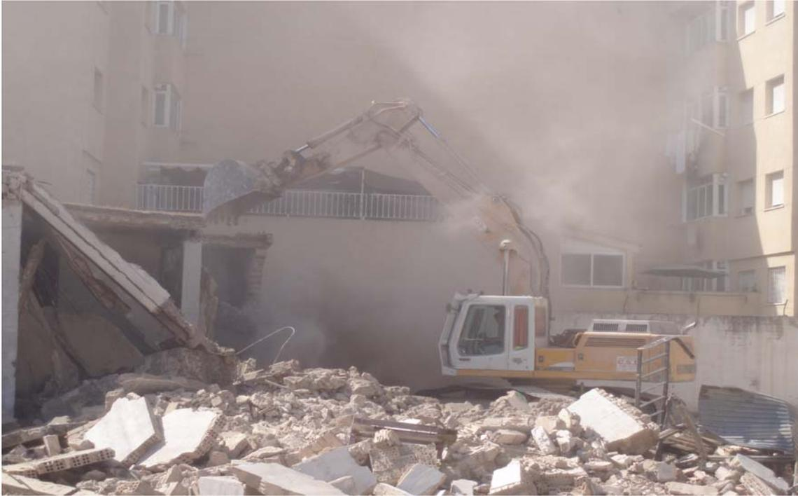
*Demolición por inestabilidad por empuje*
