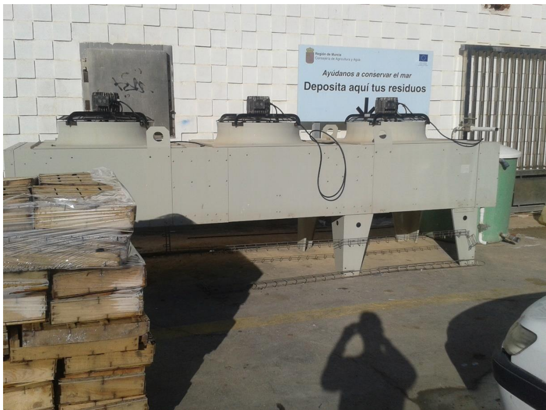
Foto N°4: Zona de depósito de residuos sólidos
