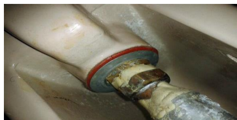
Figura 2.2 Tuberías de plomo en viviendas. Agencia de protección ambiental de los Estados Unidos(2014)
