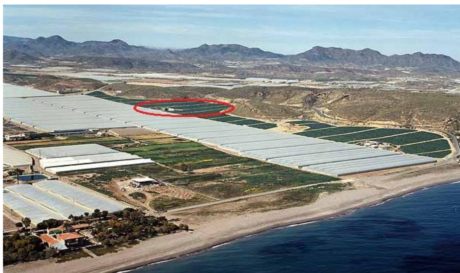
Imagen 4.2. Zona instalación de la desaladora
