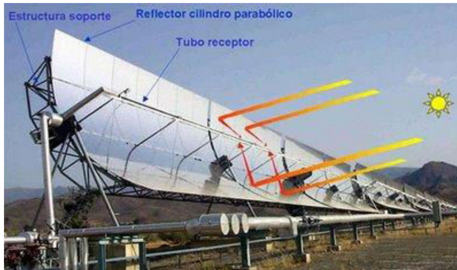
Figura 1. Esquema de PTCs (Fuente [1])
