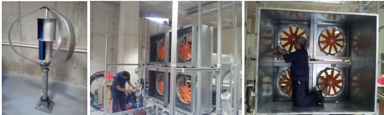
Figura 4-1 Aerogenerador DS-300 desmontado y montaje de las estructuras de la instalación
