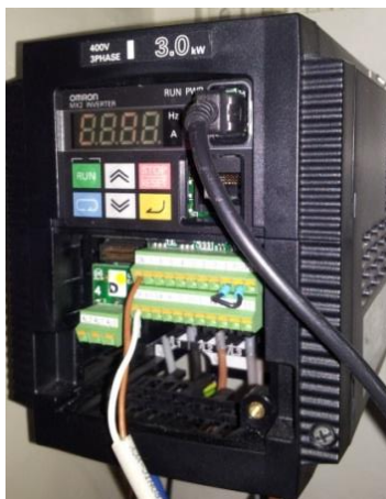
Figura 3-3 Variador de frecuencia 3G3MX2-A4030-E.
