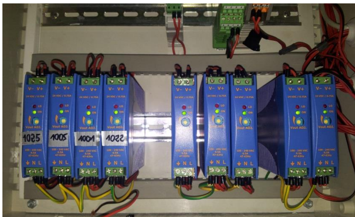
Figura 3-8 Fuentes de alimentación de 240VAC a 24 VDC.
