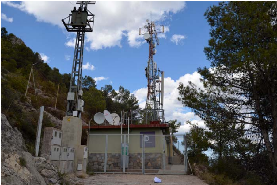
Figura 56. Recinto de telecomunicaciones.
