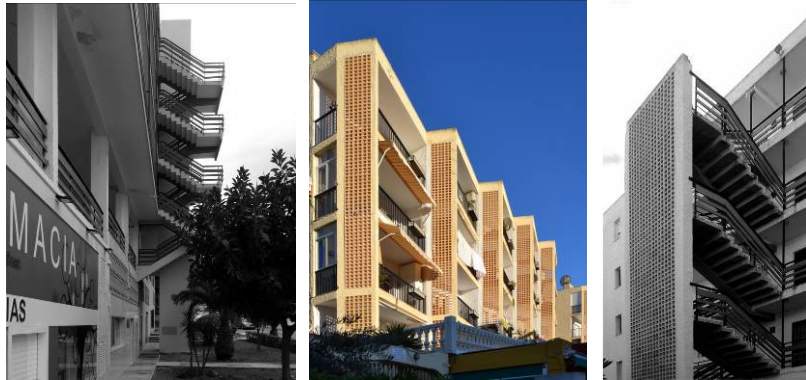
Figura 10. Escalera de El Pitaco, Aguadulce [Fotografía: los autores]. Figura 11. Vista de uno de los bloques de Las Chumberas, Roquetas de Mar [Fotografía: los autores]. Figura 12. Detalle de la escalera apoyada sobre el muro de celosía en Las Chumberas [Fotografía: los autores].
