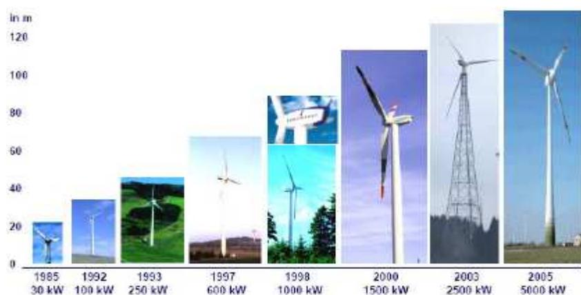
Figura 1.5. Evolución de los aerogeneradores, 1985-2005
