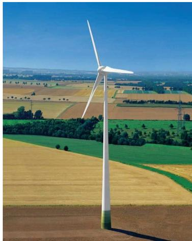
Figura 1.4. Aerogenerador actual de eje horizontal
