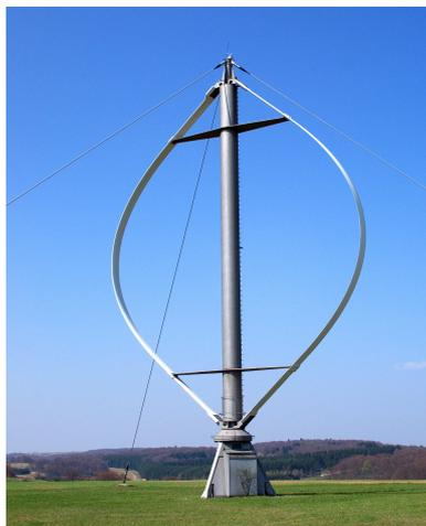
Figura 1.3. Aerogenerador Darrieus
