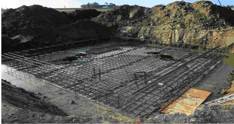
Figura6.3. Cimentación para aerogeneradores
