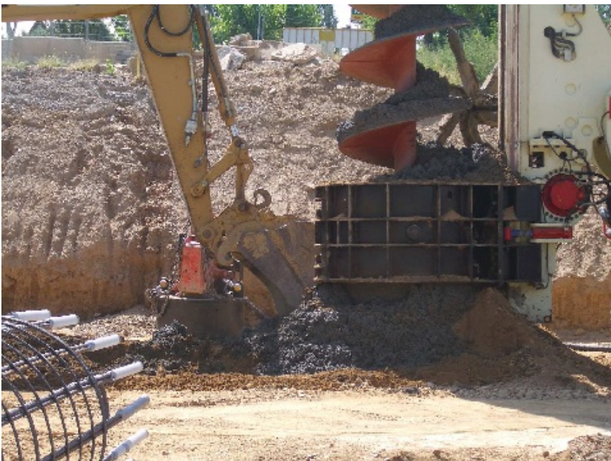
Fig. 15. Hormigonado del pilote por el tubo central de la barrena, mientras se hormigota se va extrayendo la barrena 21 .
