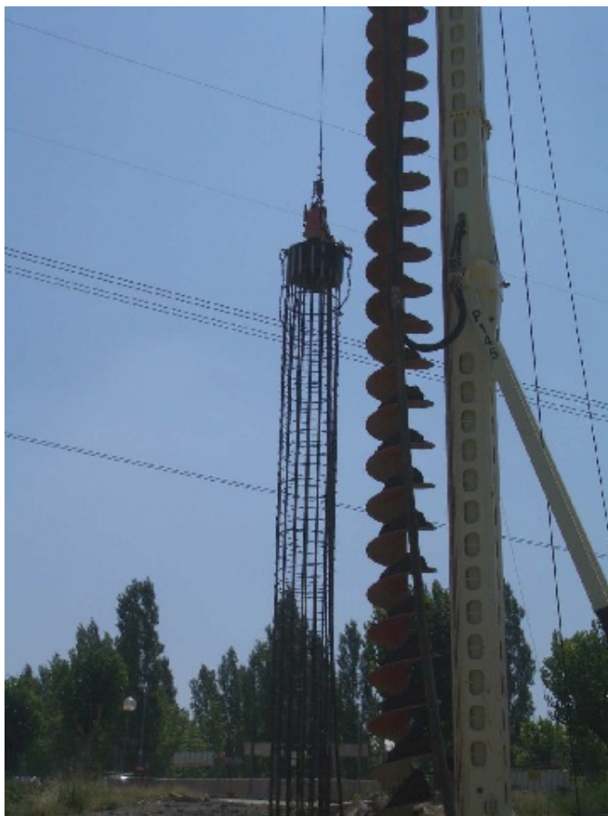
Fig. 14. Colocación de la armadura 20 .
