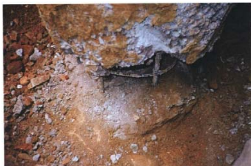
Fig. 1 y 2. Vista excavación perimetral a pilote y detalle de este con corte en la zona inferior por mala ejecución del mismo 29 .
