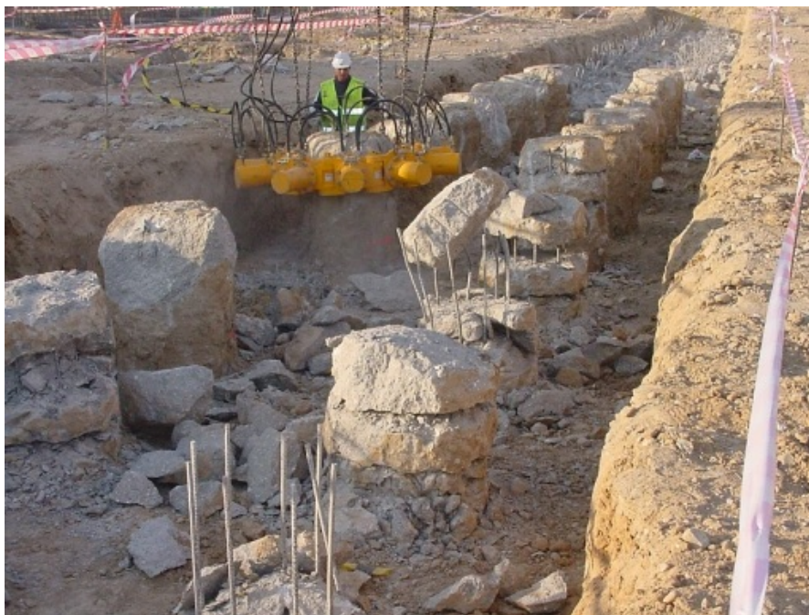
Fig. 16. Descabezado de pilotes 22
