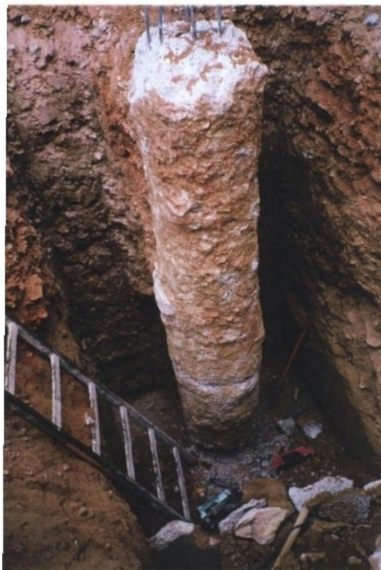
Fig. 1 y 2. Vista excavación perimetral a pilote y detalle de este con corte en la zona inferior por mala ejecución del mismo 29 .
