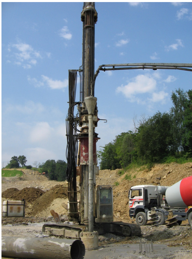
Fig. 19. Tubo tremie para hormigonado 25 .
