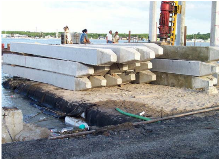
Fig. 3. Pilotes prefabricados de hormigón con punta piramidal 7 .
