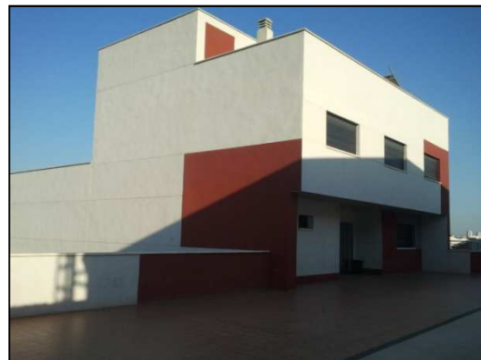
Ilustración 8 Orientación Suroeste del edificio
