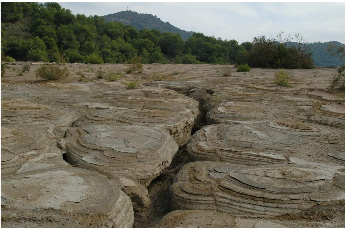
Detalle de las estructuras sedimentarias y de erosión en la balsa de estériles.
