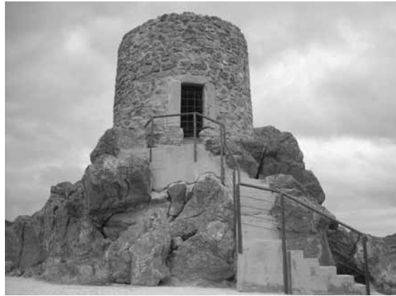
Figura 2. La Torre del Molinete restaurada. Con la escalera de acceso, en primer plano, integrada en el conjunto de la roca sobre la que asienta la torre.
