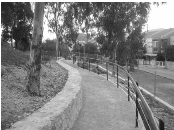
Figura 7. Estado final del camino interior del Cerro.
