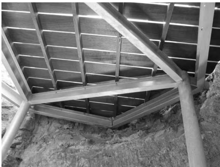
Figura 9. Detalle de la estructura metálica y de madera del interior de la Torre del Molinete.
