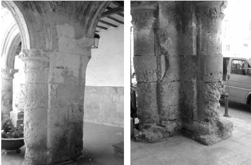
9. Factores antropogénicos: nos referimos a todas aquellas agresiones o intervenciones del hombre sobre el edificio. En este caso nos encontramos ante varias actuaciones de remodelación del pórtico que nos permiten observar algunos daños en su estructura original.
