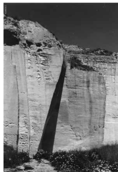
Foto 8. Estratos buzando unos 22° hacia el Norte. El contorno poligonal de la cantera permite apreciar bien la diferencia entre buzamiento real y aparente. Foto 9. Ejemplo de talud a contrapendiente por seguir un plano de diaclasa.
