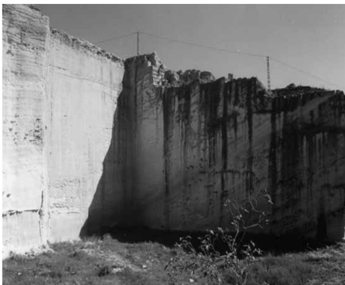
Foto 8. Estratos buzando unos 22° hacia el Norte. El contorno poligonal de la cantera permite apreciar bien la diferencia entre buzamiento real y aparente. Foto 9. Ejemplo de talud a contrapendiente por seguir un plano de diaclasa.
