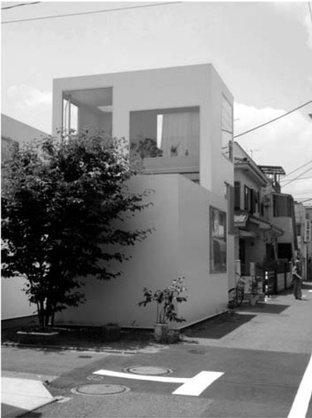
2005. CASA MORIYAMA: VISTA DESDE LA CALLE.
