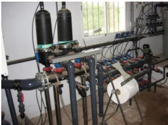
Fotografía 3. Electroválvulas y contadores de riego
