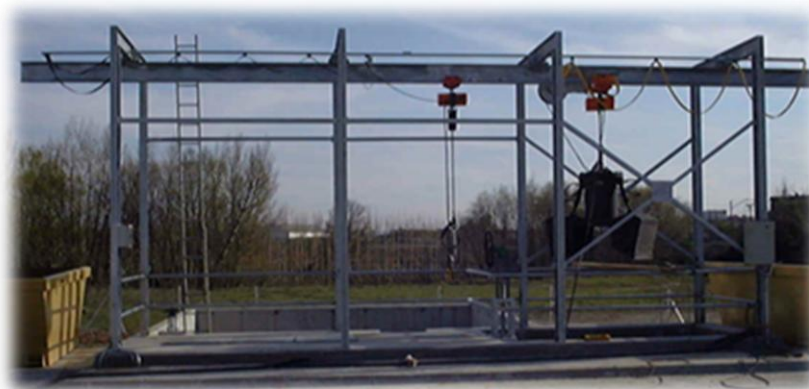
Figura 4.2.- Pozo de gruesos con cuchara bivalva
