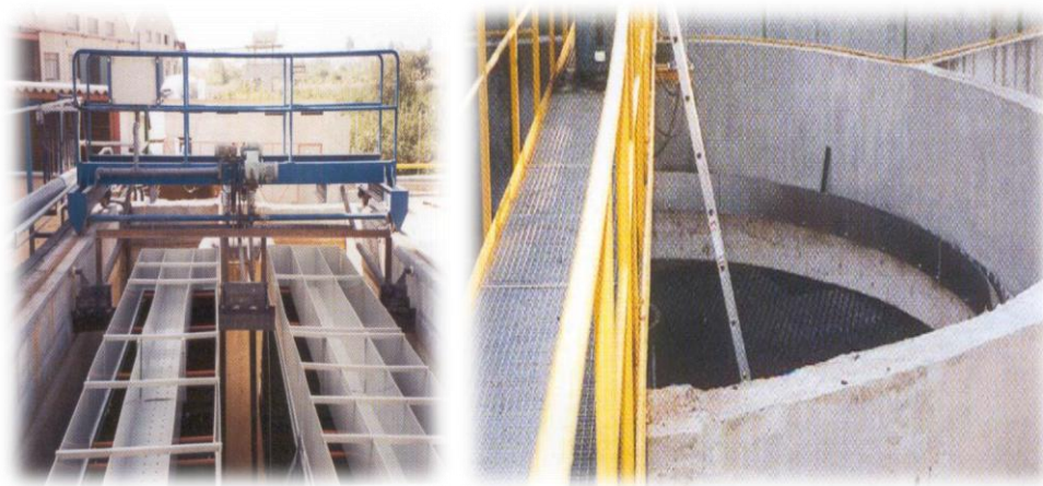
Figura 8.4.- Decantador lamelar
