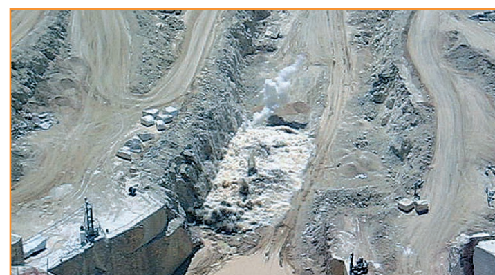
[Figura 5].- Voladura en zanja para acceso a bancos inferiores en Monte Coto de Pinoso.
