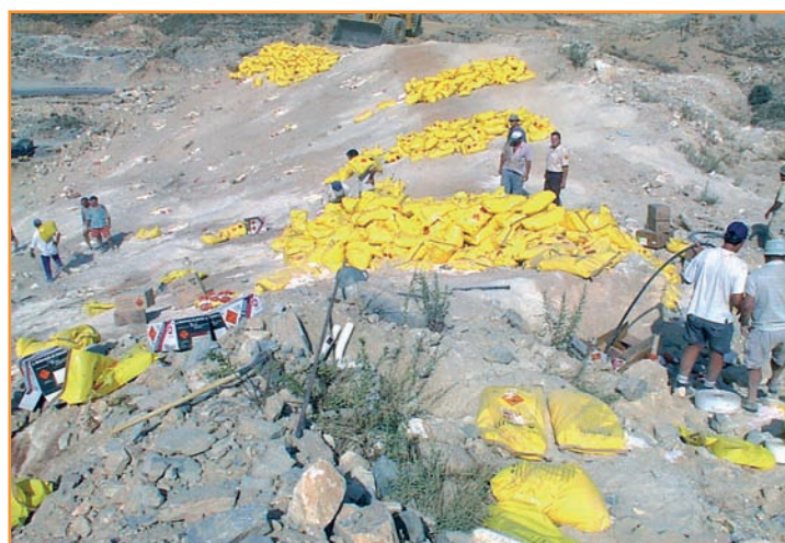
[Figura 3].- Preparación de una voladura de desmonte con 43 t.de explosivos en Macael.
