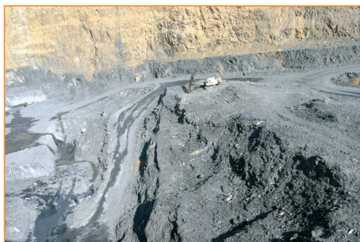
[Figura 4].- Perforación para voladura de desmonte de capa de Pizarra en Mahide (Zamora).
