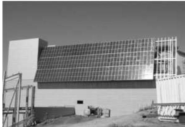
**Figura 165.** Primera instalación del mundo con células sensibilizadas con colorante en un edificio.
