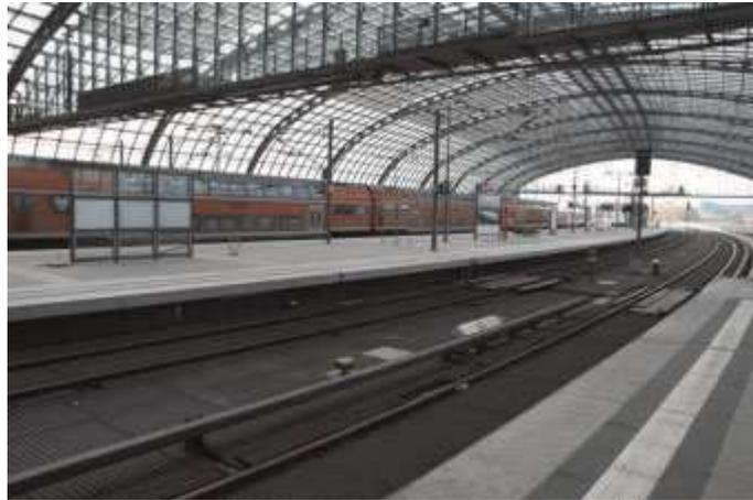
**Figura 162.** Estación de tren Lehrter en Berlín (Alemania) de módulos fotovoltaicos transparentes.
