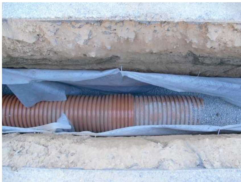
Figura 6-15. Detalle instalación zanja drenante
