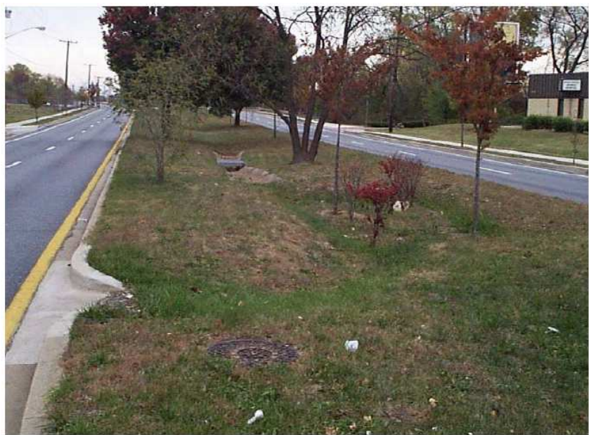
Figura 6-6. Canal recolector de escorrentía con vegetación tomado de EPA/600/R-04/121ª
