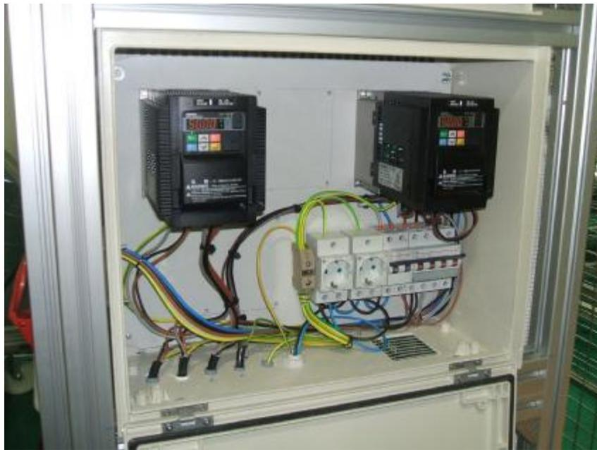
Fig. 36 Distribución de los variadores de frecuencia MX2 en la instalación
