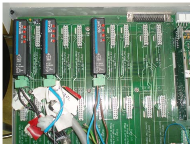
Foto 11.- Bloque de acondicionamiento
