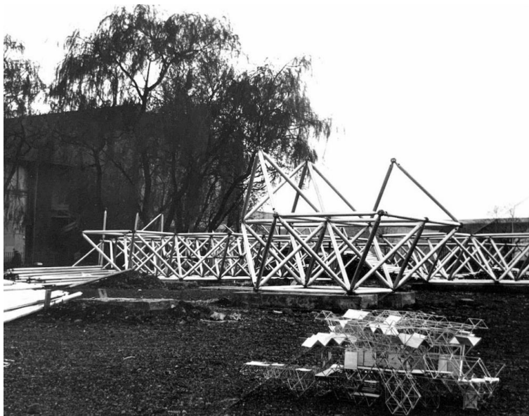
Figura 32. Maqueta en el proceso constructivo del pabellón DEUBAU de Essen
