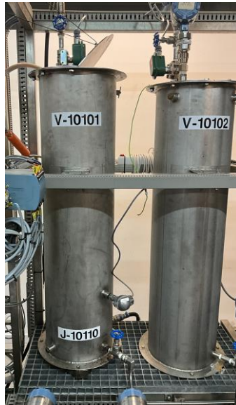
Figura 3.2: Depósitos de las líneas fría y caliente
