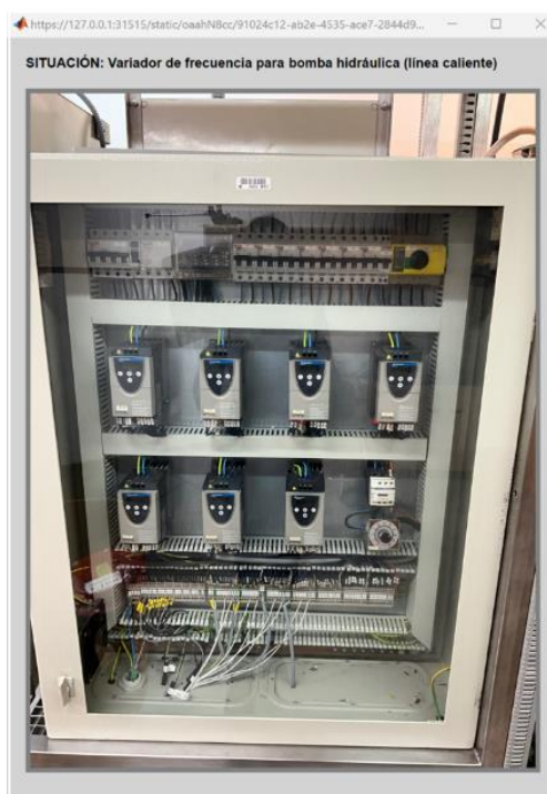
Figura 4.24: Localización 'Variadores de frecuencia'
