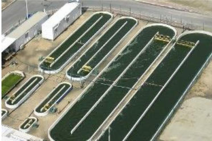
**Ilustración 3.** Sistema tipo raceway de cultivo de microalgas [10].
