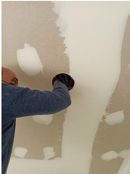
Figura 12. Colocado del módulo sensor en cámara del techo
