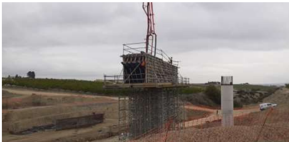
Ilustración N°24: Completado el montaje del encofrado trepante sobre la cimbra
