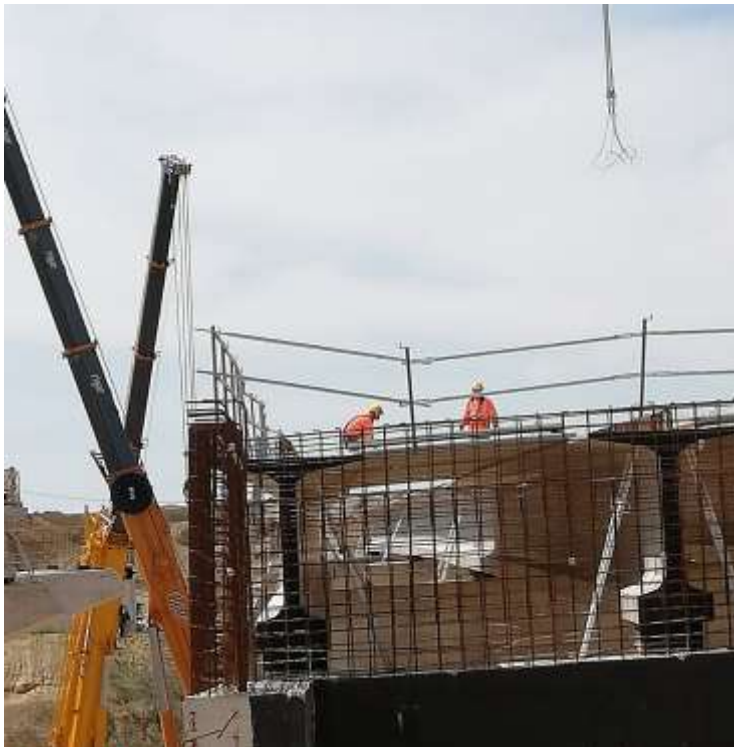
Ilustración N°38: Colocación de prelosas por dos trabajadores
