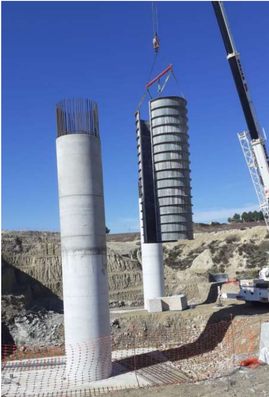
Ilustración N°21: Desencofrado del fuste
