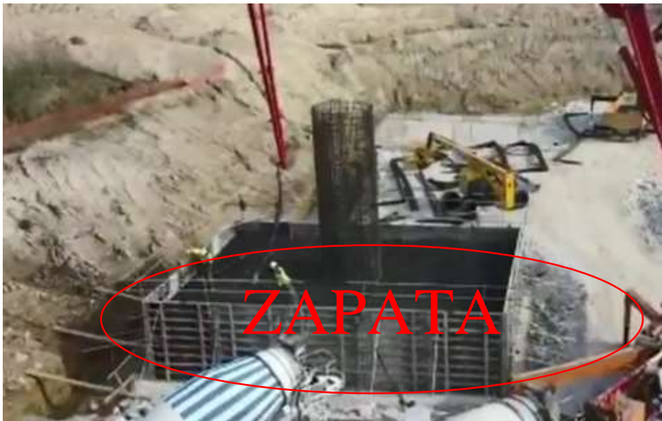
Ilustración N°17: Encofrado convencional, ferrallado y hormigonado
