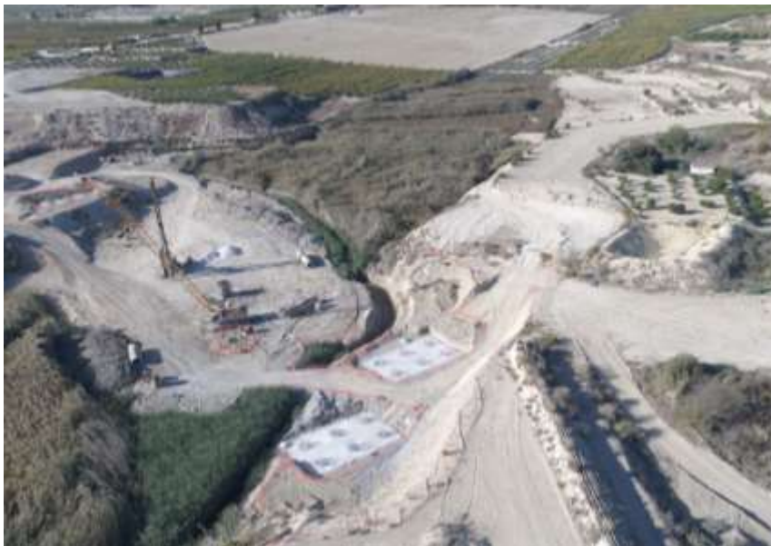
Ilustración N°16: Preparación del terreno para construir el viaducto
