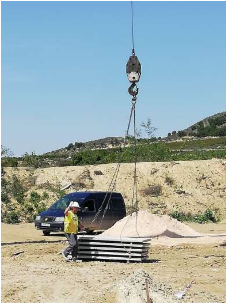
Ilustración N°33: Sujeción de prelosas para su transporte a las vigas
