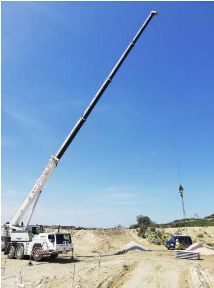
Ilustración N°32: Transporte de prelosas mediante grúa
