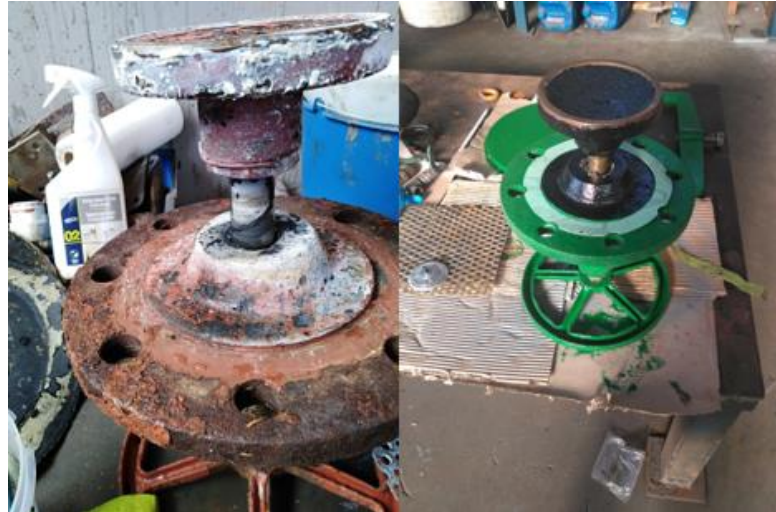
Figura 134. Reacondicionamiento grifo de fondo
