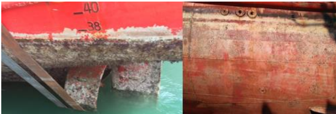
Figura 135. Limpieza de la obra viva, eliminando los microorganismos incrustados
