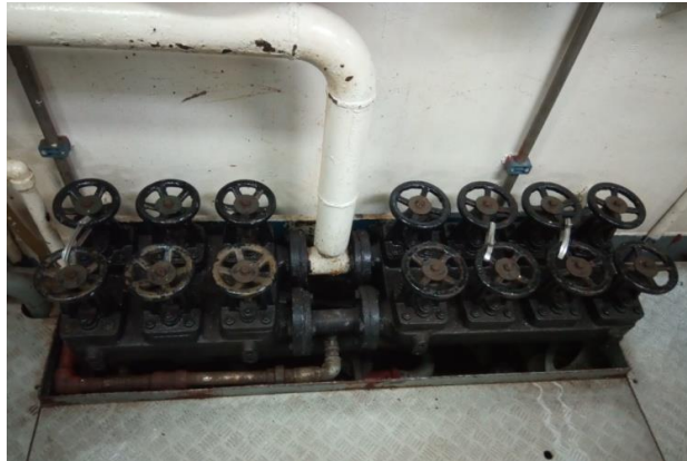
Figura 62. Piano de válvulas combustible.
