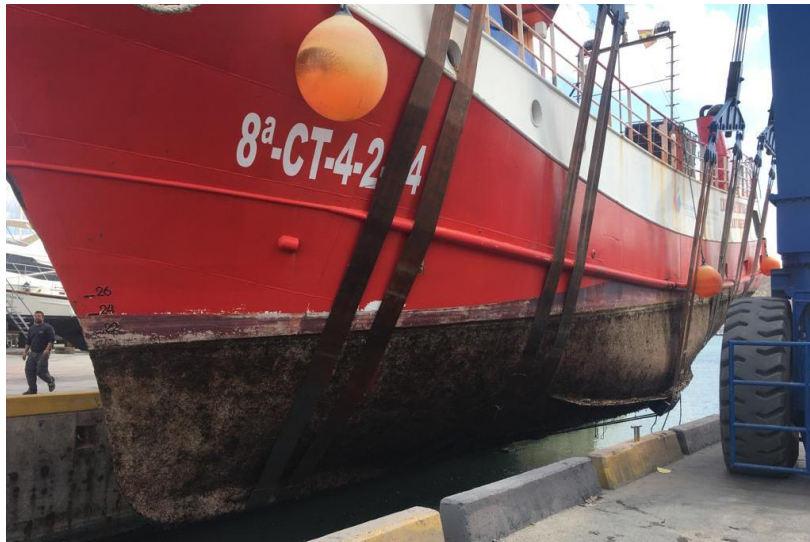
Figura 10. Detalle obra viva.
