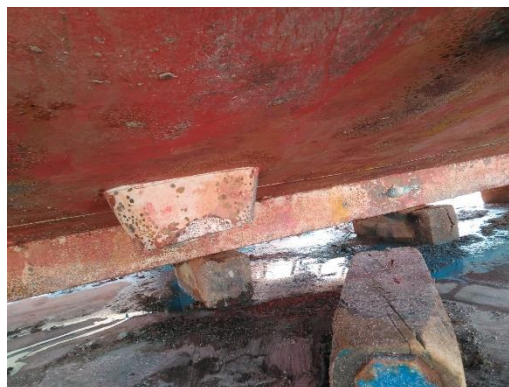
Figura 12. Toma de mar vista desde el exterior
